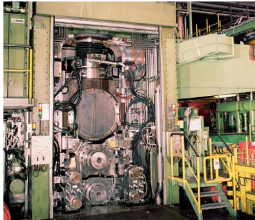
Umgebaute Walzanlage bei Corus Aluminium.
