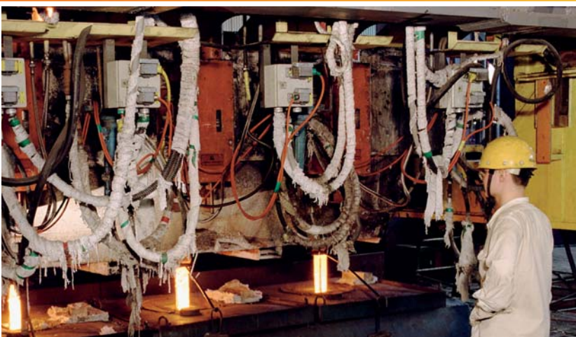
Verteilerrinne einer Vierstrang-Anlage.
